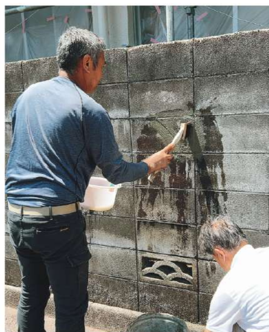
クラックの入ったブロック塀を修繕
